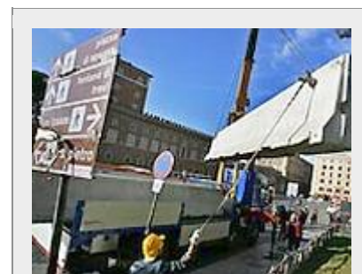
Lavori per la Metro C
