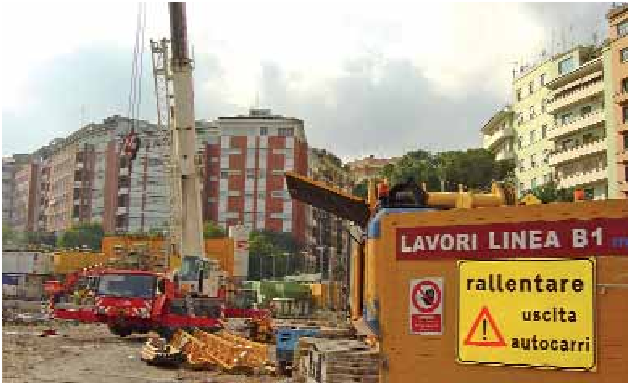
Roma: i lavori per la metro B1
