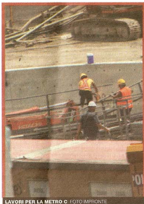
LAVORI PER LA METRO C FOTO IMPRONTE
