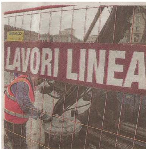
Linea C Il cantiere di una delle nuove stazioni
