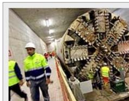
Lo scavo della galleria (Jpeg)
