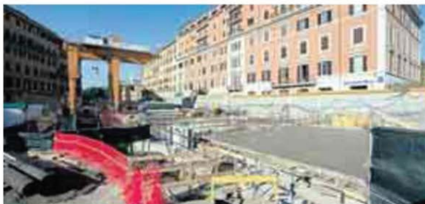
Il cantiere della Metro C a San Giovanni: i lavori sono fermi da metà dicembre per il debito del Comune con le imprese
