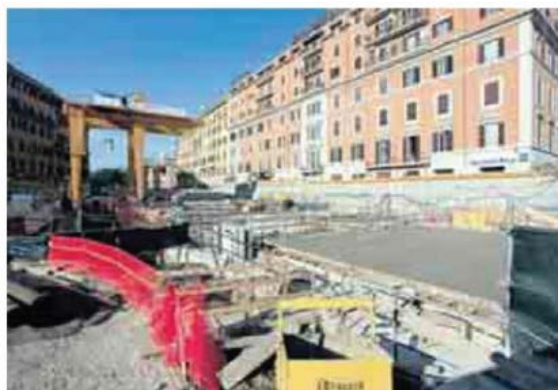
Il cantiere della Metro C a San Giovanni è fermo dalla metà di dicembre per il mancato pagamento degli arretrati alle aziende
